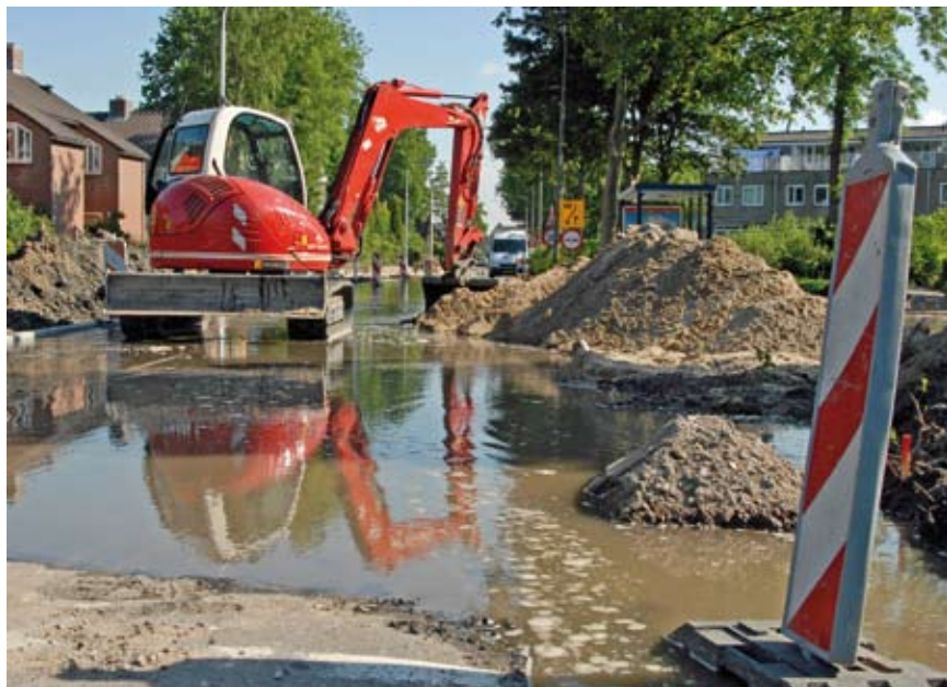
De machinist moet de tekening hebben en leidingen vooraf lokaliseren. Soms is dit lastig.
